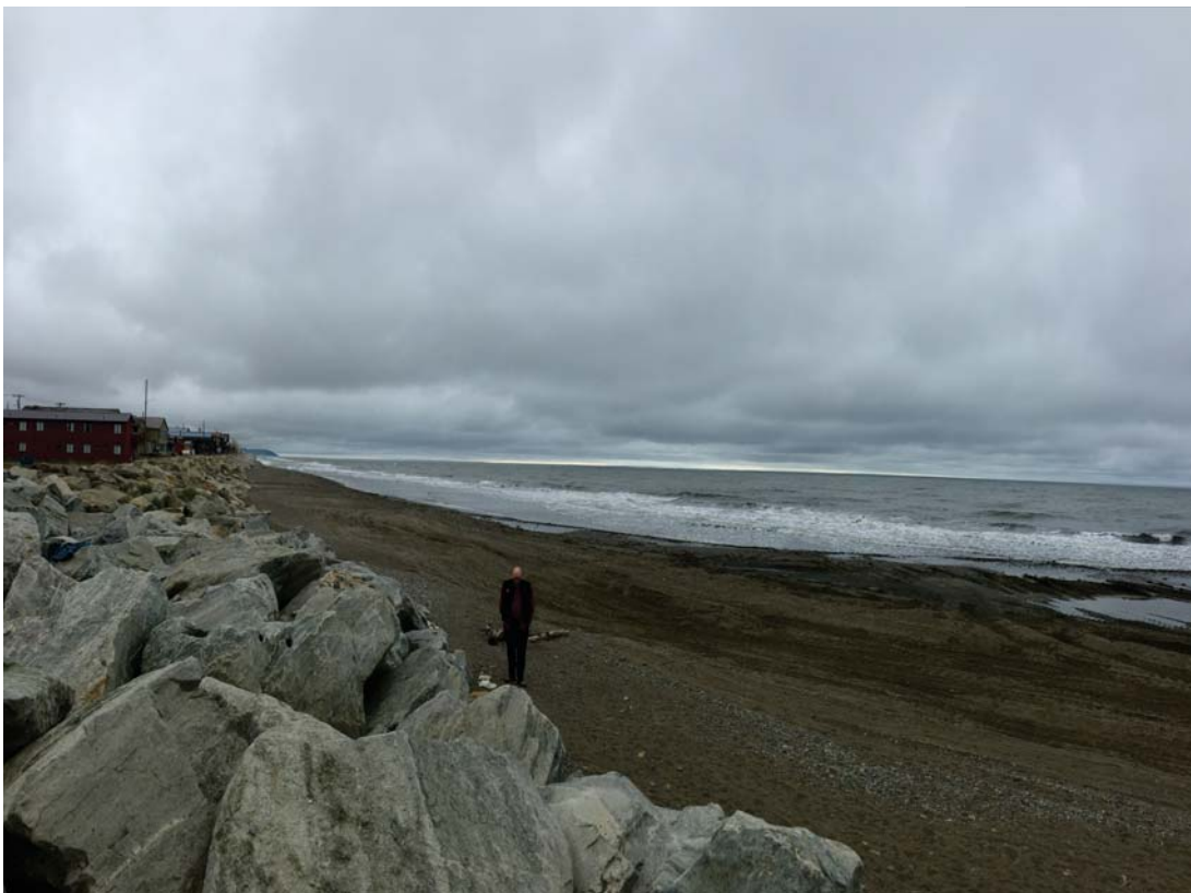
Nome Seawall, August 2015
