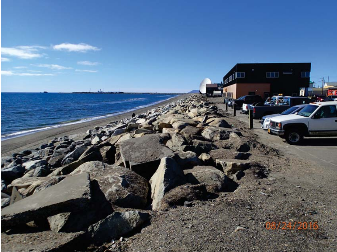
Nome Seawall, August 2016
