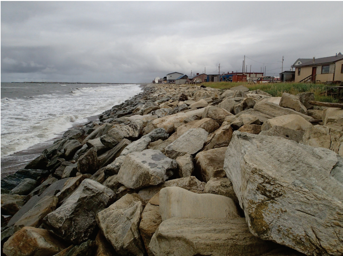
Nome Seawall, August 2018
